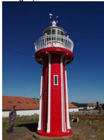
Tipo de Farolim: Enfiamento / entrada da barra Característica luminosa: Iso R 4s
