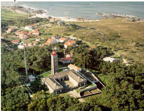
Tipo de farol: Costeiro em alvenaria pedra granítica Característica luminosa: FL (2) W 9,5s (Lt 0,2; Ec 1,7s / Lt 0,2 Ec 7,4s)
